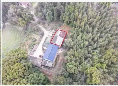
3 东北侧视角：架空线正从房屋北侧林地上方通过。
